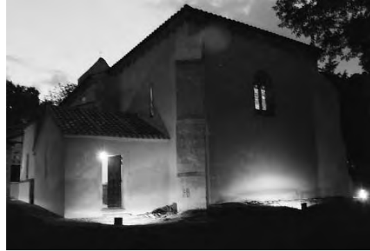
R.- Estado actual; Vista nocturna. Foto: Jesús Puras Higuera
