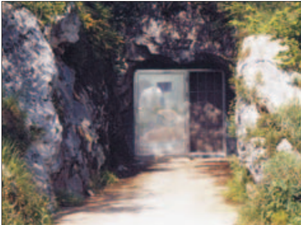
FIG. 2. Entrada de la antigua mina de La Boriza (Poo) utilizada hoy para la maduración del Cabrales. Actualmente permanecen en activo para esta finalidad catorce cuevas, tres antiguas minas, tres bodegas y dos cámaras artificiales. Destacan la ya citada mina de la Boriza y las cuevas de La Vieya, El Molín y El Cares. La primera de ellas es utilizada por ocho elaboradores; el Molín y La Vieya son usadas respectivamente por uno y seis queseros; y la cueva El Cares, que sin duda es la mayor y mejor dotada de las cuevas de maduración, es empleada por un número variable de productores.
