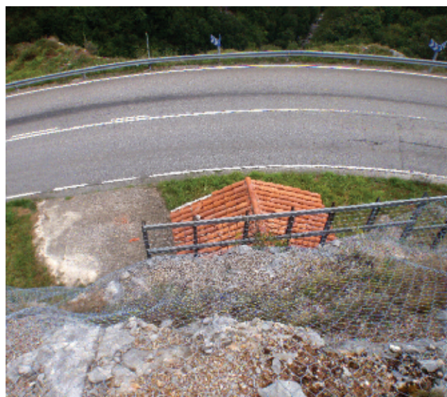
Figura 10. Vista desde arriba de la caseta de acceso a la cueva de La Covaciella (según L'Esperteyu Cavernícola)
